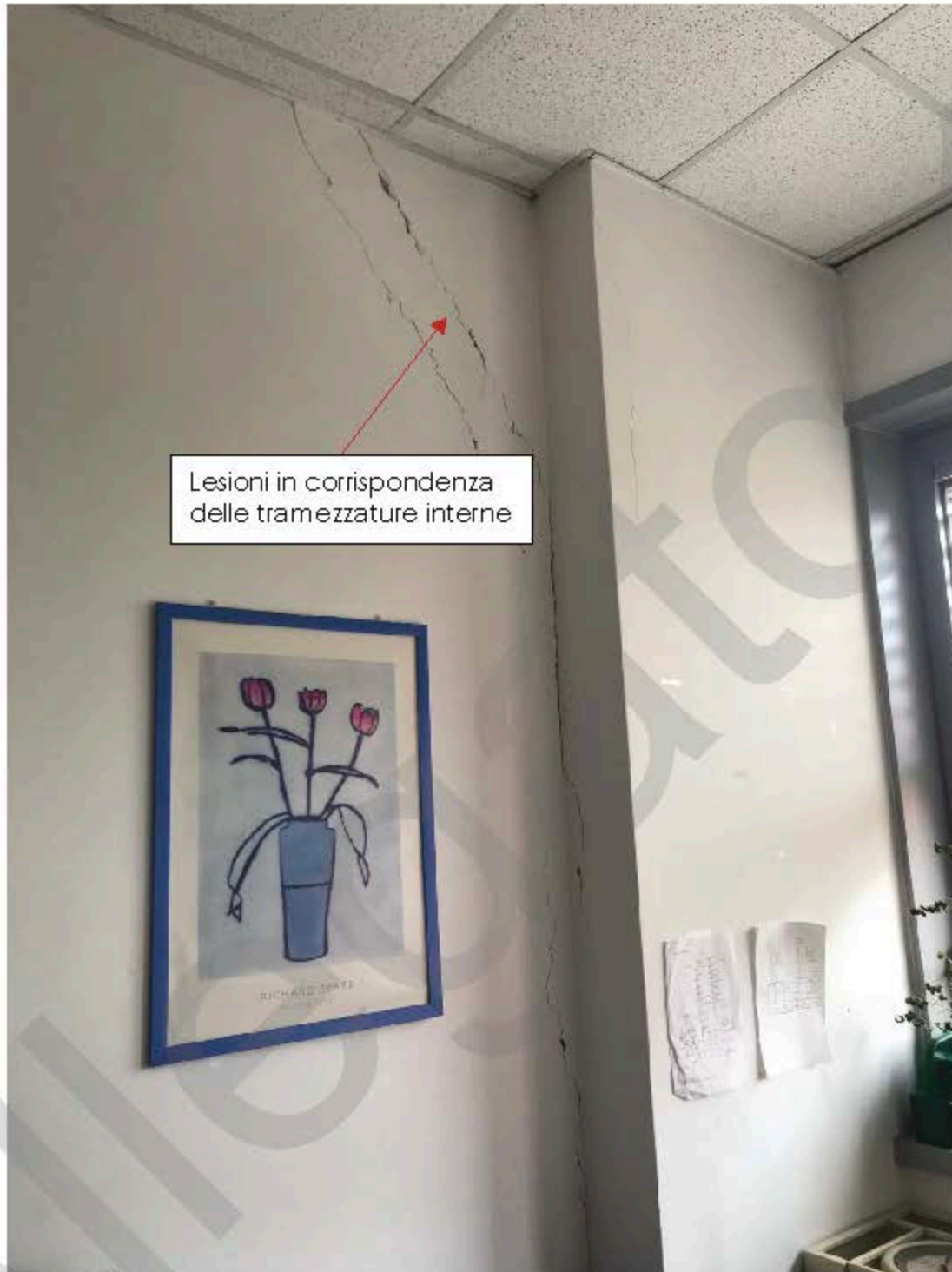
Figura 14 – Quadro fessurativo – Tramezzature interne
