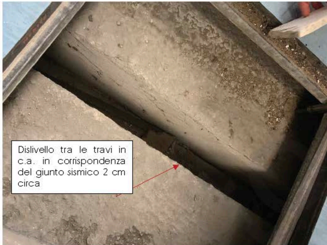
Figura 10 – Quadro fessurativo – Disallineamento travi in c.a. in corrispondenza del giunto sismico
