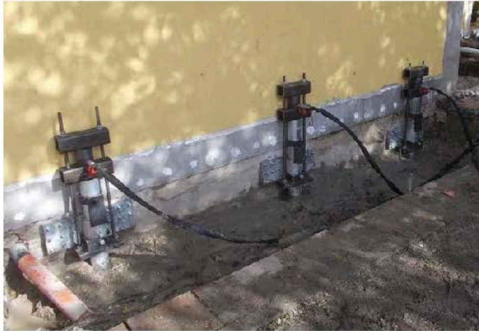
Figura 18 - Tecnica di consolidamento con palificazione attiva.
