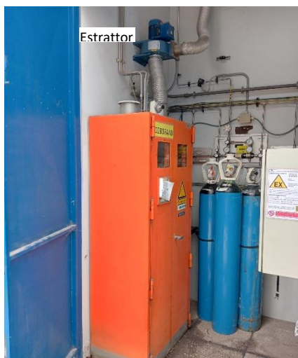
Figura 2 Gas Cabinet diborano (in arancione) e ventilatore di estrazione
