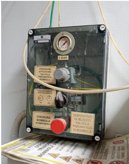
Figura 3: dispositivo di comando chiusura bombola Diborano
