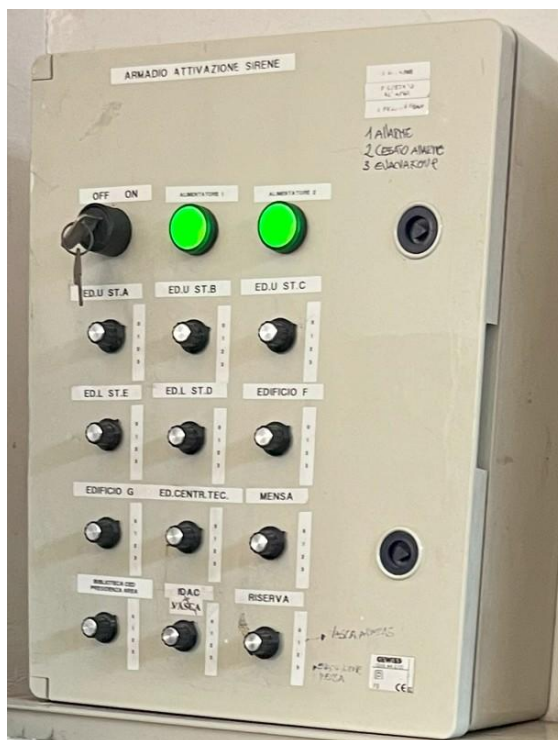
Attuale quadro attivazione segnalazione allarmi su edifici
